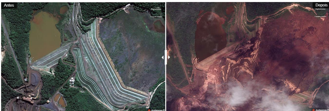
Imagem 1 –Área da Barragem I da Mina do Córrego Feijão, antes e depois do rompimento
