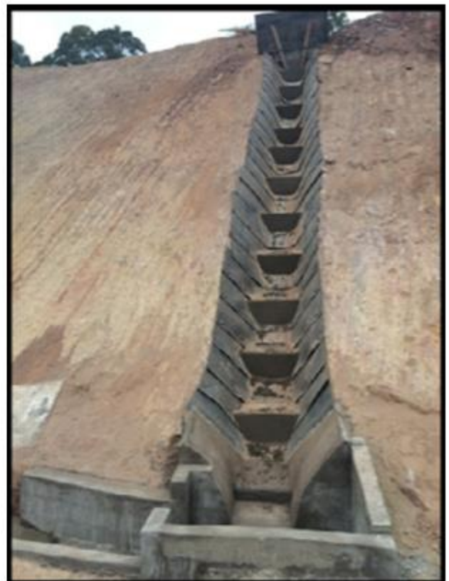
Implantação de correias transportadoras usadas
