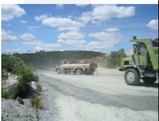
Foto 1 – Aspersão de água
