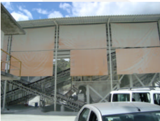
Foto 7 – Uso de lona na área de britagem de material particulado e poluição sonora.
