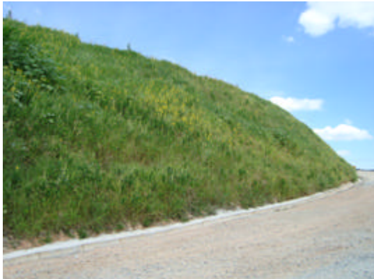
Foto 9 – Talude revegetado e canaleta de drenagem.
