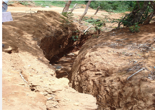
Foto 12 - Vala construída para drenar a água de chuva do interior da vala de rejeitos, conduzindo a um sumidouro
