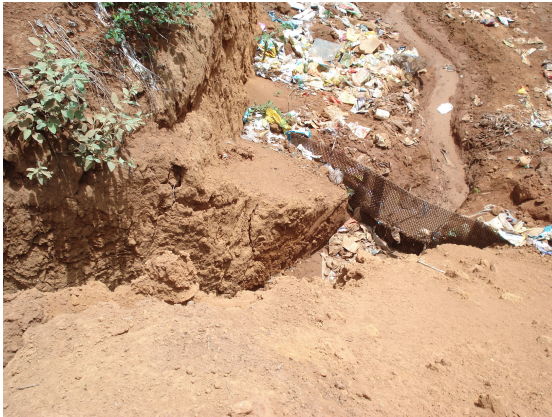
Foto 11 – Vala construída para drenar a água de chuva do interior da vala de rejeitos
