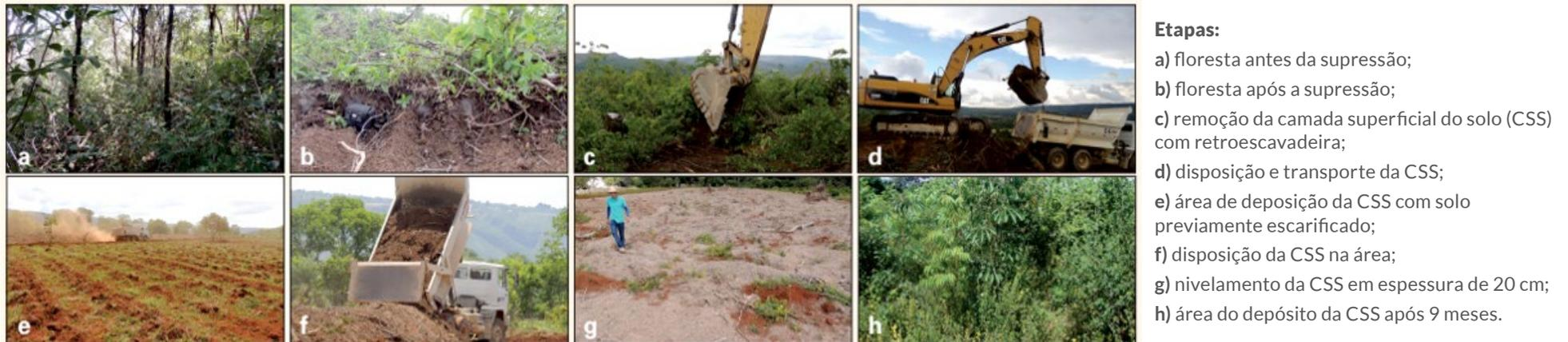
**Figura 13.** Etapas da transposição da camada superficial do solo
