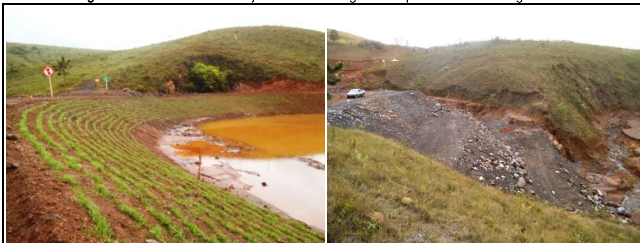
Figura 13: Vista do talude de jusante da Barragem B3 após as obras emergenciais.
