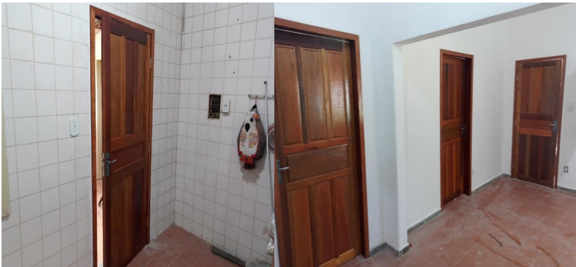
Figura 10. Casa das Flores: Finalização do verniz nas portas.
