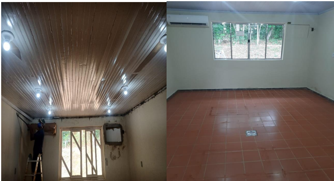
Figura 14. Herbário: Substituição de todo forro de madeira por de PVC, pinturas das paredes e substituição da janela que apresentavam sinais de envelhecimento.
