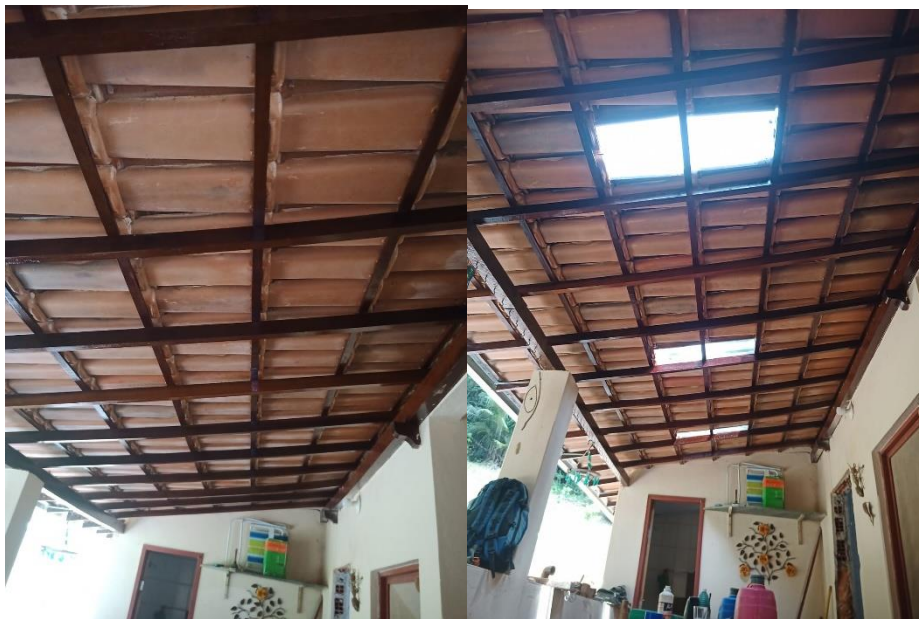
Figura 6. Casa das Flores: Substituição das telhas convencionais por telhas transparentes com a finalidade de assim permitem a entrada de luz natural, reduzindo a necessidade de iluminação artificial e proporcionando economia de energia.
