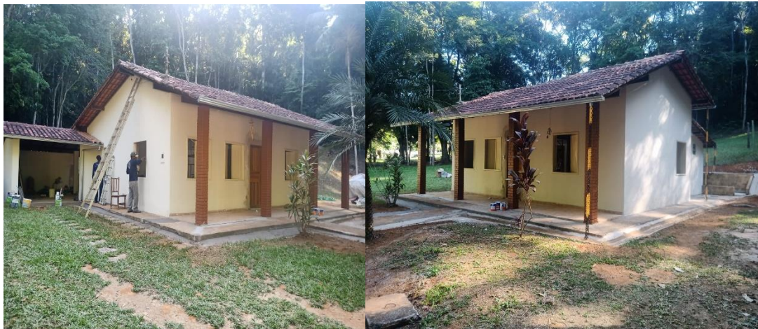
Figura 5. Casa das Flores: Finalização da pintura em toda área externa.
