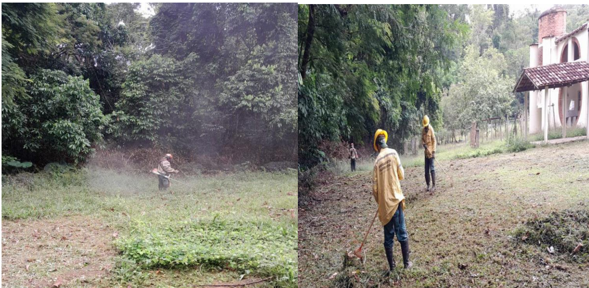
Figura 14. Estruturas: em andamento podas mecanizadas de grama no entorno das estruturas do PERD com finalidade de evitar o crescimento excessivo da vegetação.
