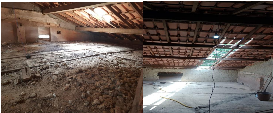
Figura 16. Alojamentos Centro de Treinamento: Em andamento limpezas de entulhos, resíduos de morcegos e demais rejeitos encontrados nos alojamentos.
