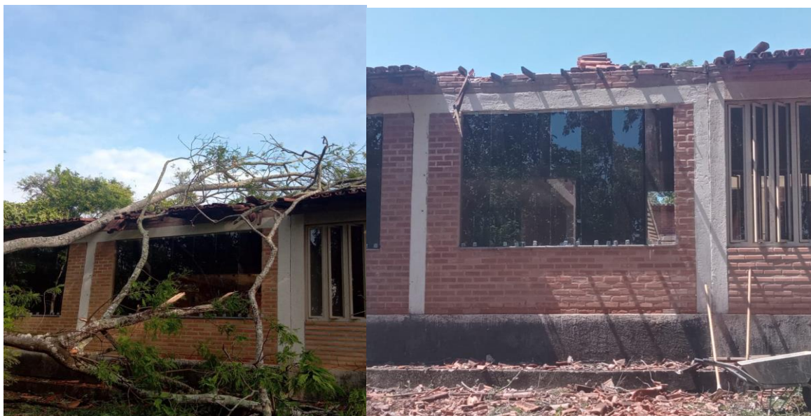
Figura 2. Centro de Treinamento: Retirada da árvore caída decorrente de forte chuvas sobre o telhado de uma das salas de treinamento.
