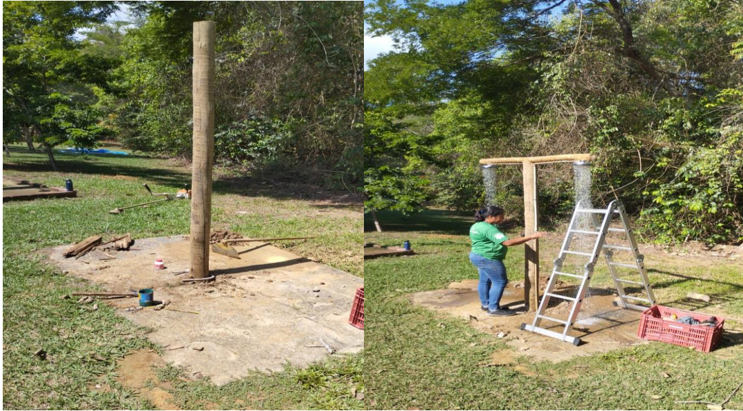
Figura 7. Duchas: Reformas das duchas ao ar livre nas áreas de uso públicas. A modernização da infraestrutura é para garantir eficiência no consumo de água e substituições por materiais duráveis que resistam às condições climáticas.
