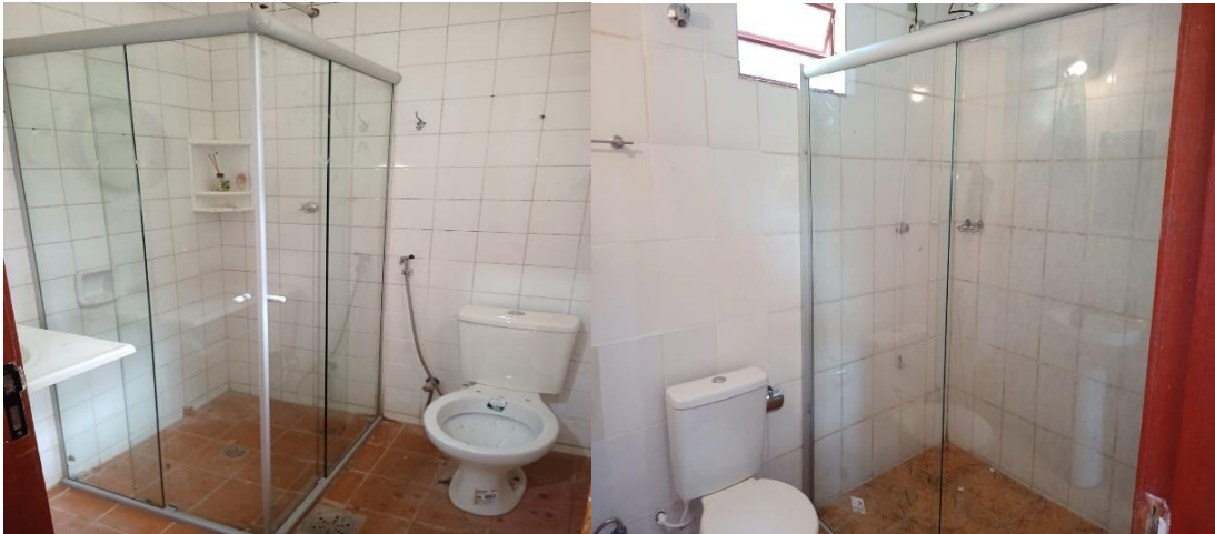
Figura 5. Casa das Flores: Substituições dos boxes dos banheiros.
