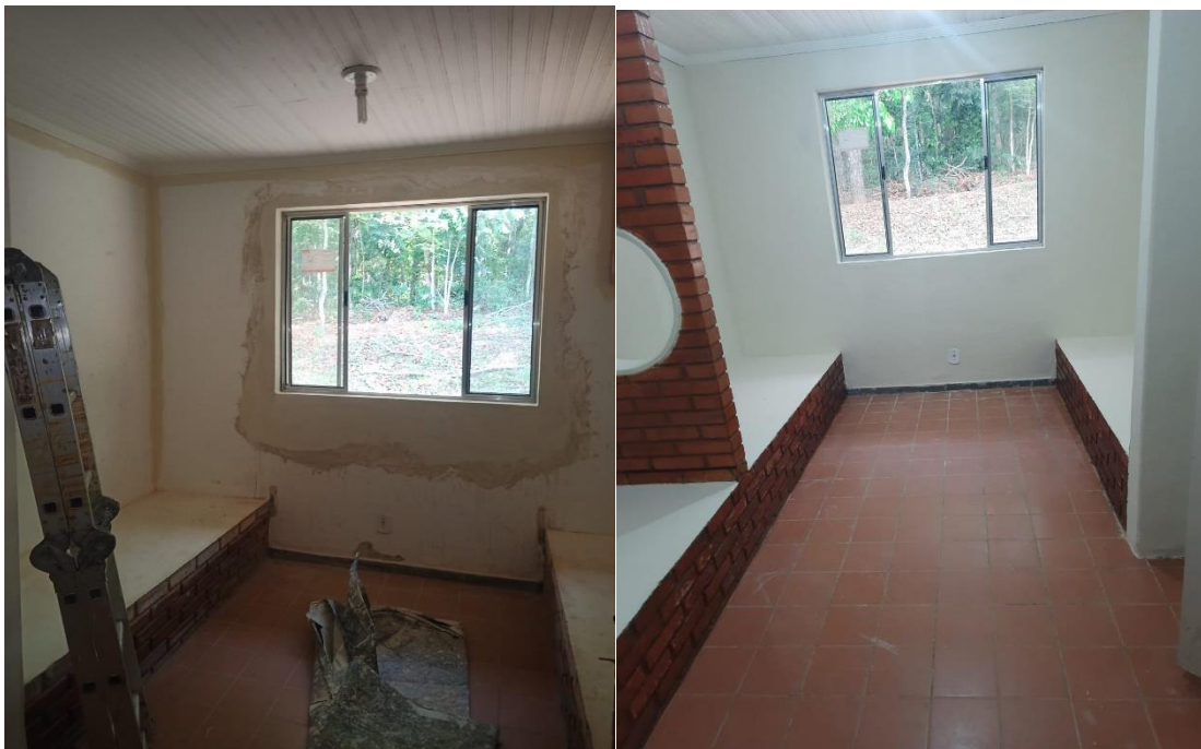
Figura 09. Alojamento de apoio curadoria: Pinturas das paredes de alojamento ao lado do Herbário.
