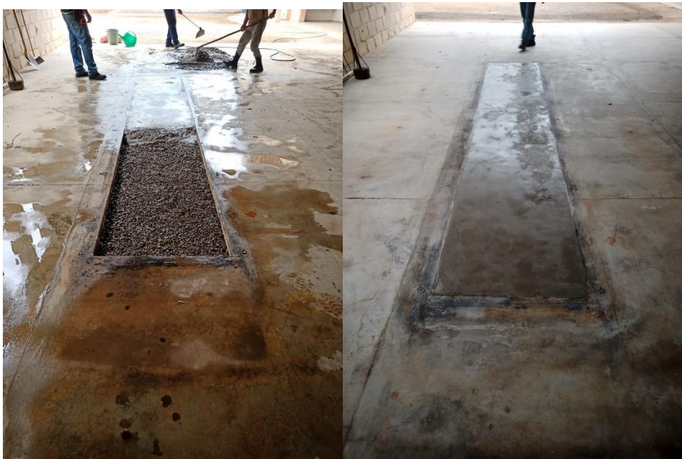
Figura 08. Vedação de vala com concreto armado: A vedação impede o acesso não autorizado a valas, reduzindo significativamente o risco de acidentes, quedas ou lesões.
