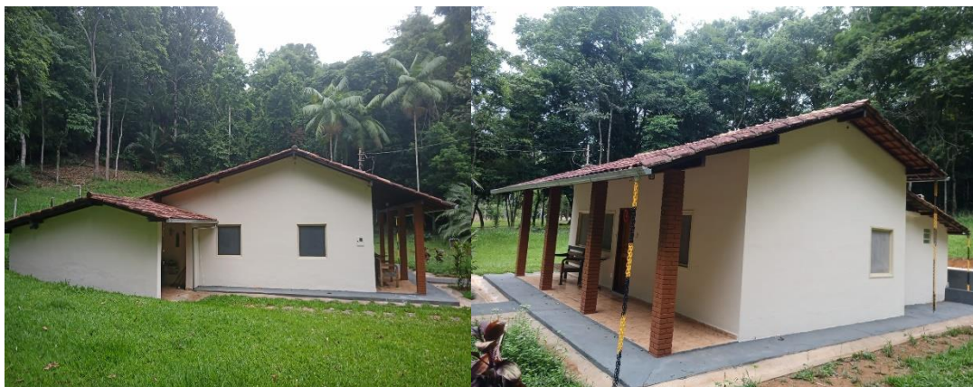
Figura 5. Casa das Flores: Finalização da manutenção, atendendo aos requisitos previamente acordados.
