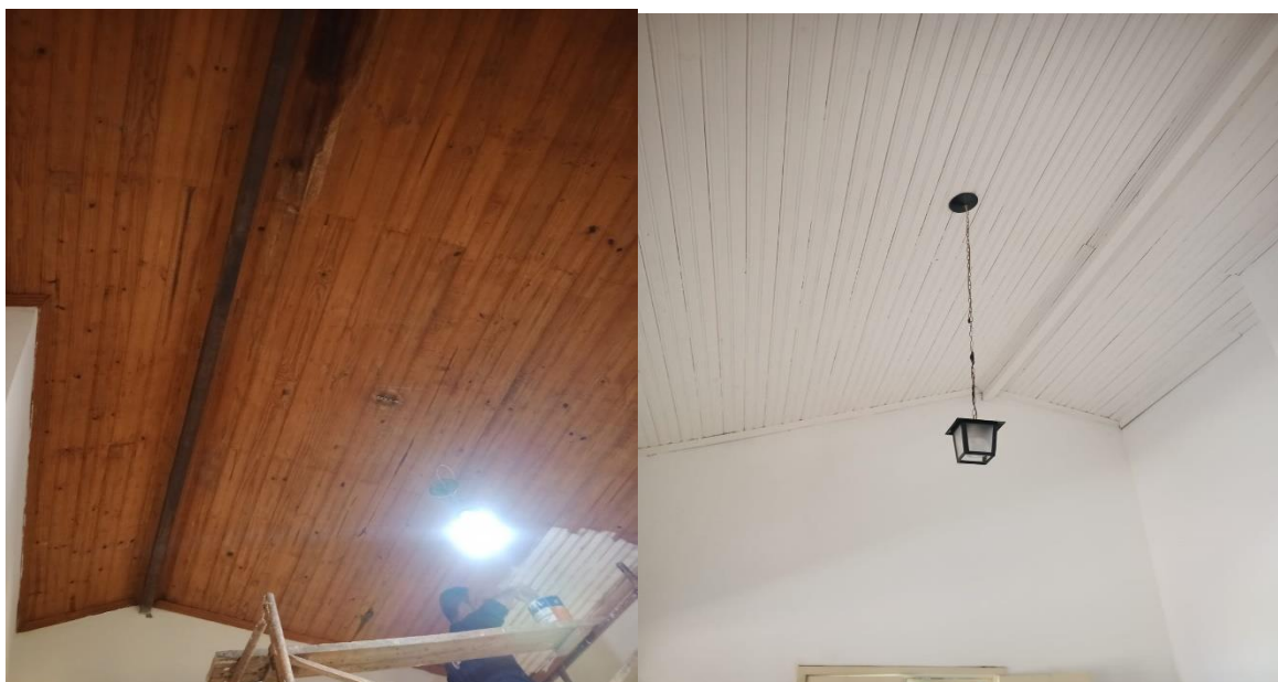
Figura 6. Casa das Flores: Em andamento pintura de todo forro de madeira existente no interior da estrutura com finalidade de proteger contra danos causados por insetos, umidades, ajudando a preservar a madeira e prolongando sua durabilidade e resistência ao longo do tempo.
