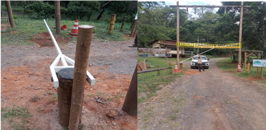
Figuras 11. Salão Dourado: Implantação de uma cancela manual temporária até as próximas manutenções.
