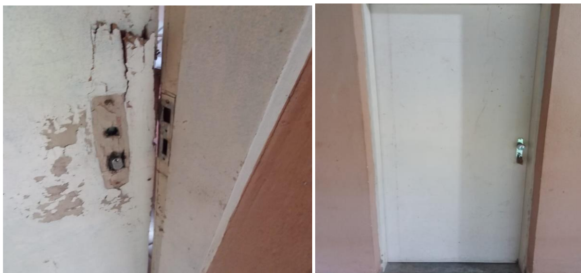
Figura 10. Campo de pouso: Reparo da fechadura da porta principal do alojamento bloco 3 no campo de pouso para garantir a segurança e integridade da instalação, prevenindo acessos não autorizados e assegurando um ambiente adequado para os ocupantes.
