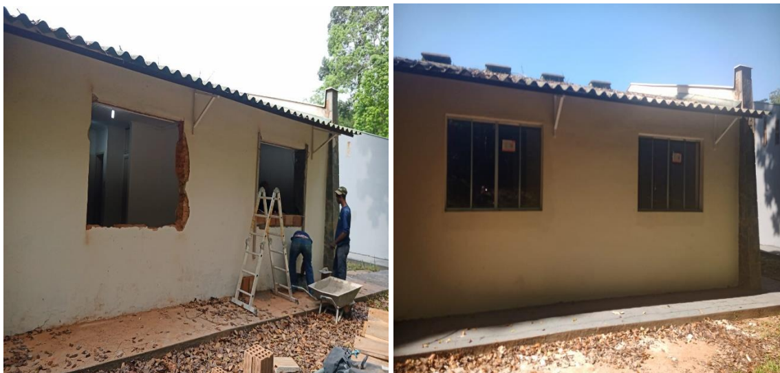
Figura 10. Alojamento de apoio curadoria: Substituições das janelas que apresentavam sinais de envelhecimento, comprometendo a eficiência e a segurança do ambiente.
