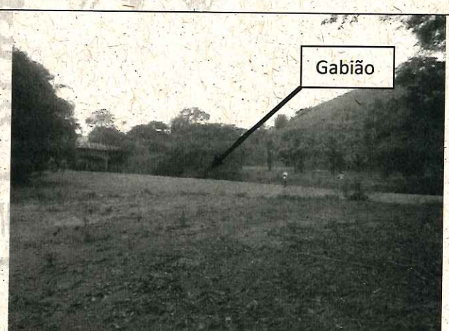
Imagem 2: Vista da área de intervenção em APP.
