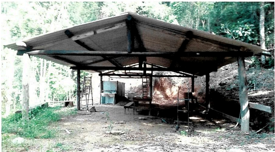
Galpão recém construído
