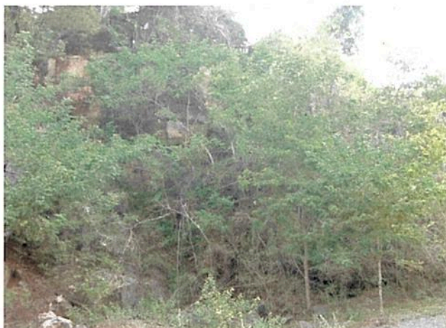
Figura 09 – Detalhe de paredão no interior da área.
