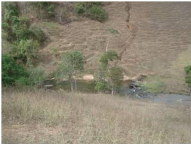
Foto 01. Vista geral do local onde será instalada a barragem e área parcial que será inundada.
