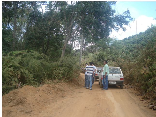
Foto 02. Vista geral do local onde será instalada a barragem e estrada que será inundada.
