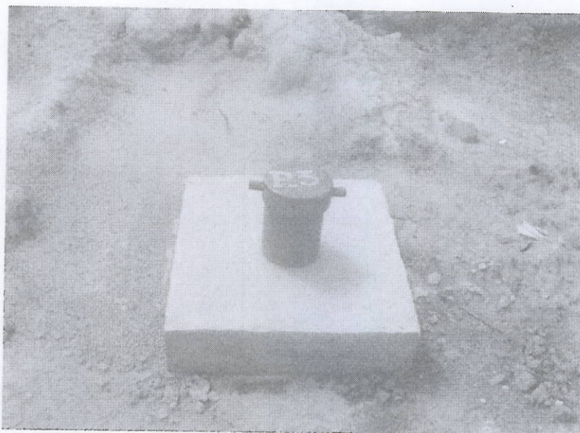
Foto 15 – Poço de Monitoramento construído no entorno da cava C
