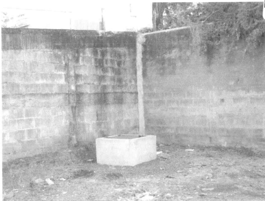
Vista da Caixa Protetora do poço localizada no canto SW da propriedade.
