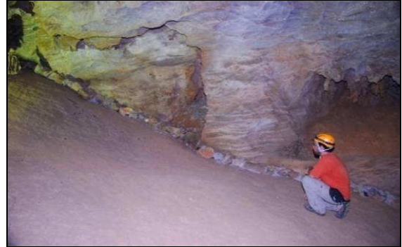
B – Linha de pequenos blocos, espeleotemas e argamassa, para ocultar cabos elétricos. Foto: V. Moura.
