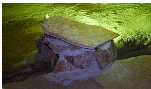
C – Anteparo com uso de blocos e lâminas de rocha fixados por argamassa, no Salão da Couve-flor. Foto: V. Moura.
