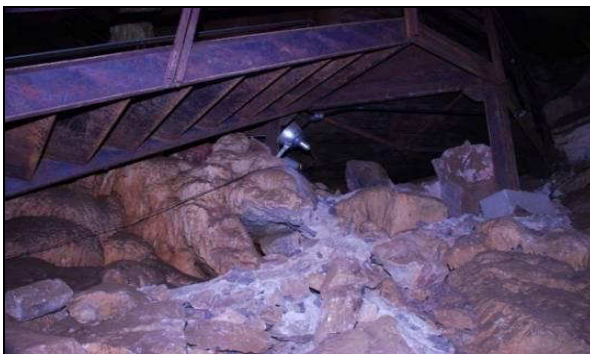
E – Cordões de argamassa e blocos para ocultar cabeamento elétrico. Neste local todo o cabeamento e luminárias poderiam ter sido instalados na passarela, sem impactos diretos para a caverna. Local: “Salão dos Blocos desabados”. Foto: V. Moura.
