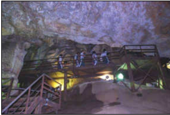
A – Vista de trecho da passarela com passagem a grande altura, onde a proteção do guarda-corpo é mais necessária. Foto: V. Moura.
