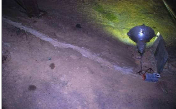
A – Instalação de cordão de argamassa aderido à capa estalagmítica, com o intuito de ocultar o cabeamento elétrico. Foto: V. Moura.
